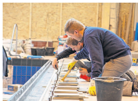
ALLES MUSS PASSEN: Stück für Stück schaffen die Fliesenleger den nahtlosen Anschluss vom Springerbecken an den Umlaufbereich, der im gesamten Schwimmbad neu gefliest wird.
