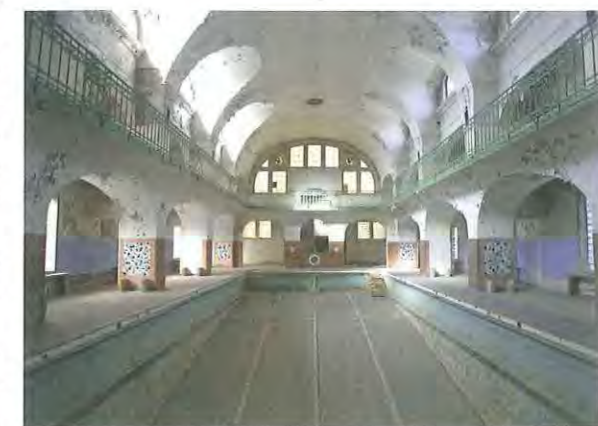
Im historischen Bad musste der mit Gefälle verlaufende Boden des Beckens herausgenommen werden, um eine einheitliche Wassertiefe von 1,35 m zu schaffen Foto: Veauthier Meyer Architekten
