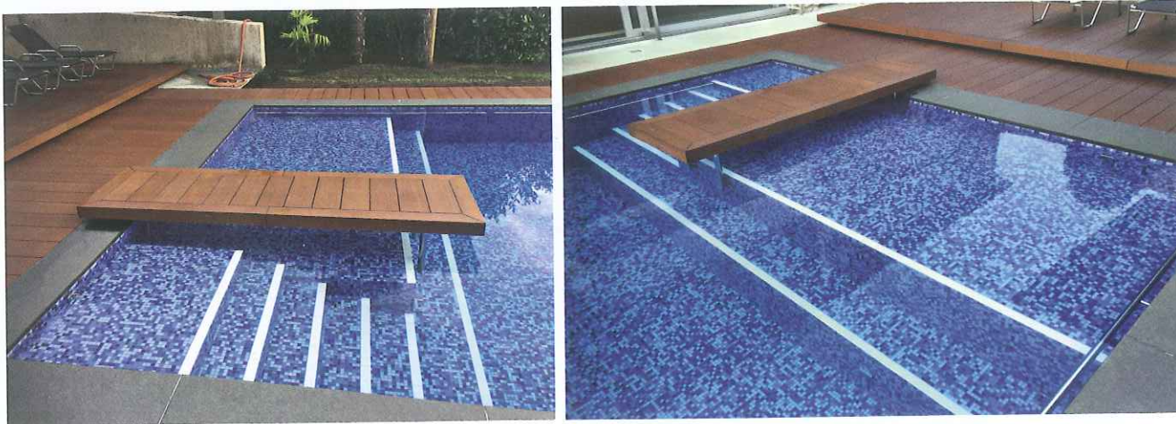
Das alte Becken wurde entfernt, der Beton neu aufprofiliert und dann die Flächen mit dem STEULER-Q 2 -Abdichtungssystem ausgekleidet. Statt der keramischen Mosaik aus der Vergangenheit wurden im Pool jetzt Glasmosaik verlegt, die ein interessantes Licht im Beckenwasser erzeugen.
