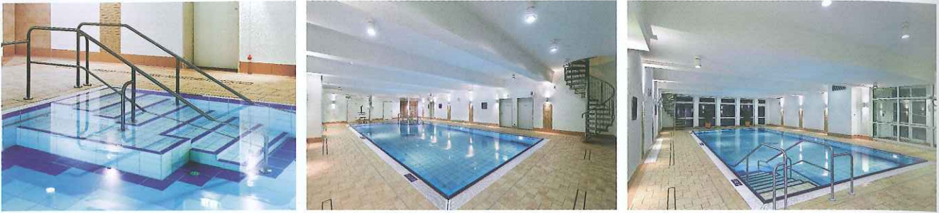
Da der Betrieb des Therapiebades so wenig wie möglich beeinträchtigt werden durfte, musste die Sanierung des Schwimmbeckens in kürzester Zeit durchgeführt werden. Das Becken erhielt eine Q 2 -Abdichtung von STEULER-KCH, die jetzt die Dichtheit des Beckens auf Jahre hinaus garantiert.
