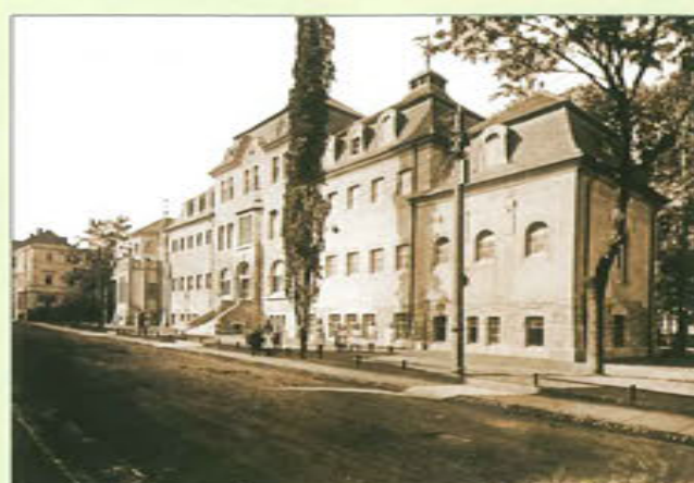
■ Altes Stadtbad (alle 1909); Fotos: Denkmalamt, Gotha
