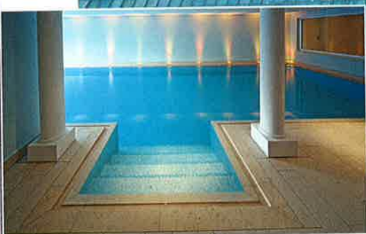
Das Schwimmbecken wurde mit einer STEULER-Q 2 -Abdichtung versehen und dann mit Mosaikfliesen ausgekleidet. Dabei ist die Überlaufrinne eine Eigenkonstruktion und wurde speziell für dieses Projekt angefertigt.
