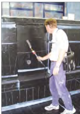
■ Nach dem Verkleben der Gummifolie: Hochspannungsprüfung auf Dichtigkeit; Foto: Steuler, Höhr-Grenzhausen
