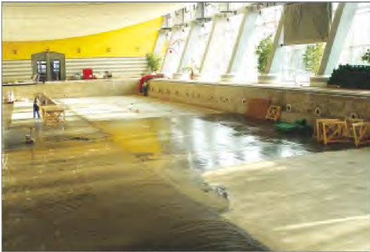
■ Auftrag der leitfähigen Epoxidharz-Untergrundspachtelung; Foto: Steuler, Höhr-Grenzhausen
