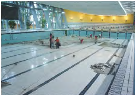
■ Schadensbild: großflächige Aufwölbung der Beckenbodenfliesen einschließlich Abdichtung – mit darunter stehendem Wasser; Fotos (ohne weitere Quellenangabe): Volker Fornacon, Erfurt
