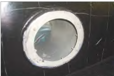
■ Folienanschluss des Unterwasserscheinwerfer-Einbautopfes mit Dichtflansch
