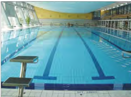
■ Das 50-m-Schwimmerbecken der Erfurter Südschwimmhalle nach der Sanierung
