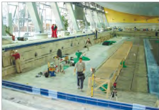
■ Setzen der Überlaufrinne nach Einbringen der Haft- und Schutzspachtelung
