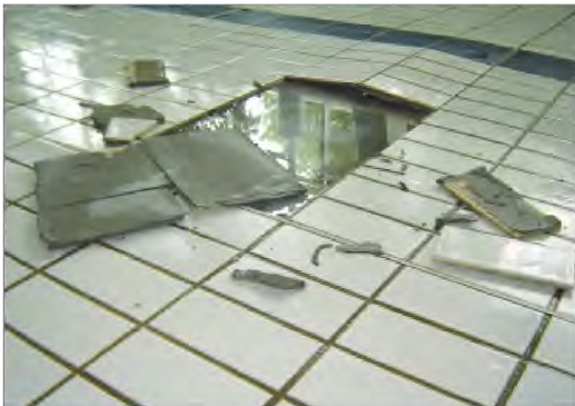
■ Schadensbild: großflächige Aufwölbung der Beckenbodenfliesen einschließlich Abdichtung – mit darunter stehendem Wasser; Fotos (ohne weitere Quellenangabe): Volker Fornacon, Erfurt
