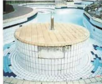
Nach erheblichen Fliesenschäden durch Frost, beschloss man in Gersthofen die vorhandenen Becken komplett zu sanieren. Bereits die Abbrucharbeiten wurden unter einem Zelt durchgeführt. Ein trockenes und frostfreies Arbeiten war für alle Bauschritte extrem wichtig.
