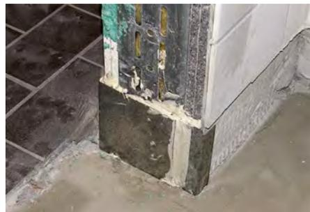
Abb. 52: Im Zuge der anschließenden Sanierung zusätzlich angeklebtes Blech, an dem anschließend die neue AIV seitlich hochgeführt werden kann
