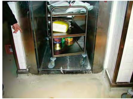
Abb. 49: Fehlende Entwässerungsrinne am Fußbodenabschluss vor dem Schacht des Lastenaufzugs einer Großküche
