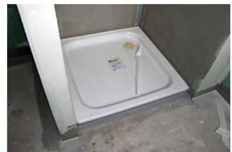
Abb. 56: Nicht den Hinweisen des ZDB-Merkblatts entsprechender Einbau der Duschwanne
