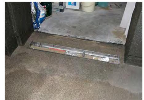
Abb. 46: Entwässerungsrinne im Türdurchgang zwischen Spülküche (hoch beanspruchter Nassraum) und Trockenraum
