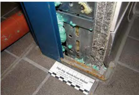
Abb. 51: Fehlende seitliche Hochführung der AIV bei einer Türleibung einer Trockenbauwand trotz des Vorhandenseins einer zweiteiligen Stahlzarge
