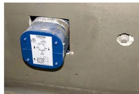
Abb. 35: Fertig gestellte AIV mit noch ausstehender Abdichtung der Durchdringung und der Unterputzarmatur
