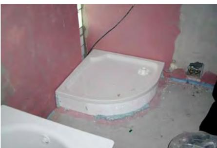
Abb. 54: Unter dem EPS-Wannenträger einer Dusche angeordnete AIV
