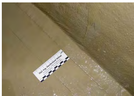
Abb. 29: Fertiggestellte Wandabdichtung mit den beiden vorhandenen Vlieseinlagen
