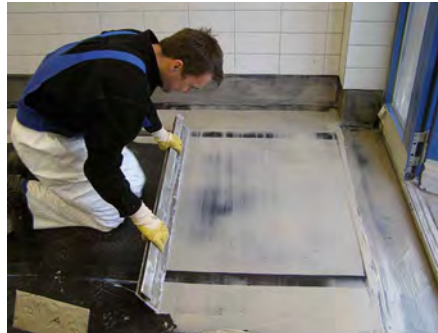
Abb. 12 und 13: AIV aus 2,0 mm dicker Butylkautschukbahn in einer LKW-Waschhalle vor und bei Aufbringung der Ausgleichs- und Schutzspachtelung (aus [9])
