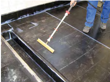
Abb. 12 und 13: AIV aus 2,0 mm dicker Butylkautschukbahn in einer LKW-Waschhalle vor und bei Aufbringung der Ausgleichs- und Schutzspachtelung (aus [9])
