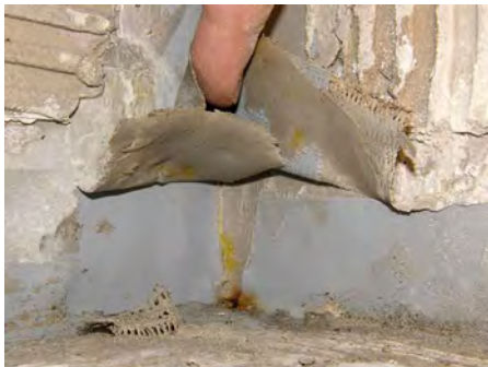
Abb. 23 und 24: Nicht fachgerechter Einbau der Dichtbänder
