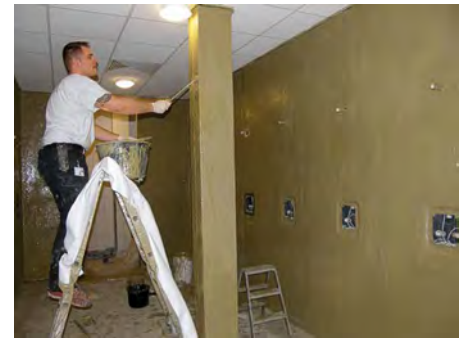
Abb. 8: Vliesarmierte Reaktionsharzabdichtung
