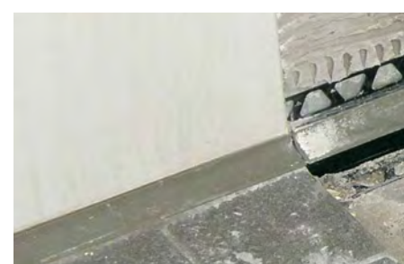
Abb. 21 und 22: Alternative zu elastisch verfüllten Estrichrandfugen
