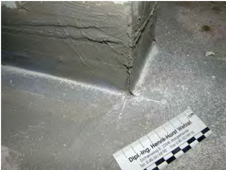
Abb. 23 und 24: Nicht fachgerechter Einbau der Dichtbänder
