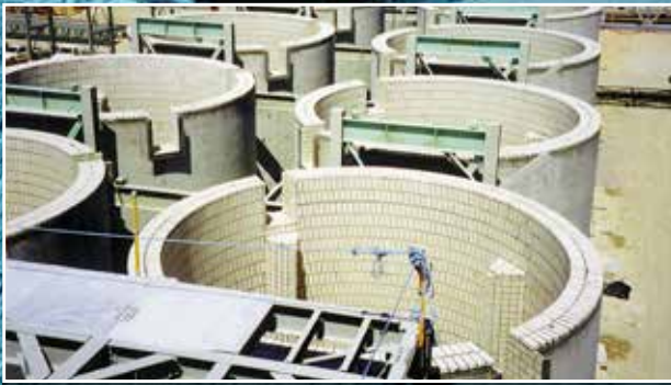
Systemauskleidung mit keramischen Steinen.
