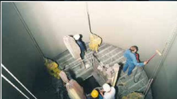
Dichtheitsprüfung einer Kamin-Beschichtung.
