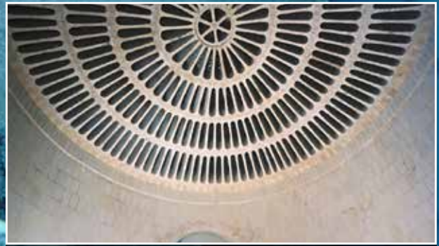
Selbsttragender Stufenkuppelrost in einem Absorptionsturm.
