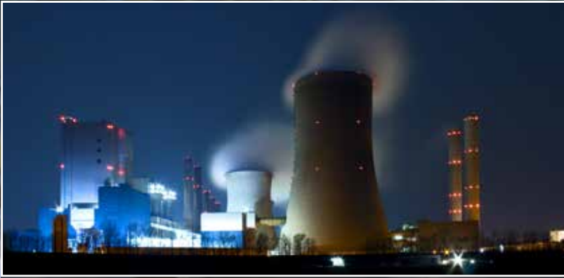
Komplexe Korrosionsschutzleistungen in Kraftwerken.
