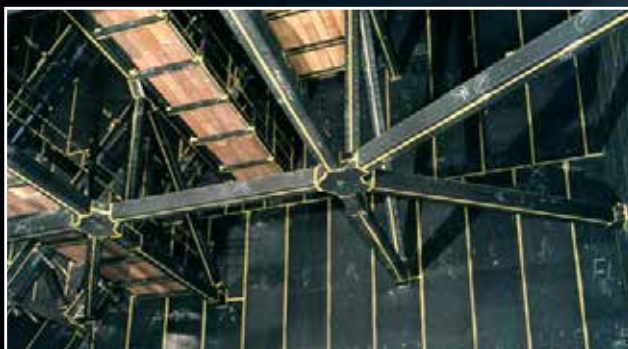
Gummierung in einem Rauchgaswäscher.
