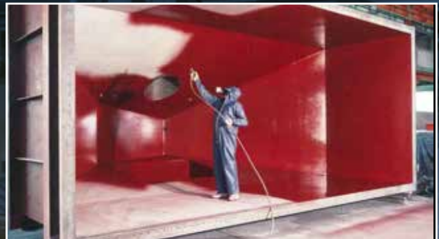
Spritzapplikation einer Beschichtung mit Barrierefüllstoffen.
