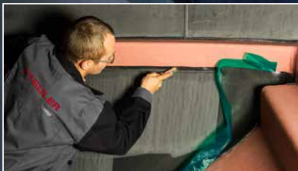
Kontrollierte Bedingungen: Ausführung einer Werksgummierung.
